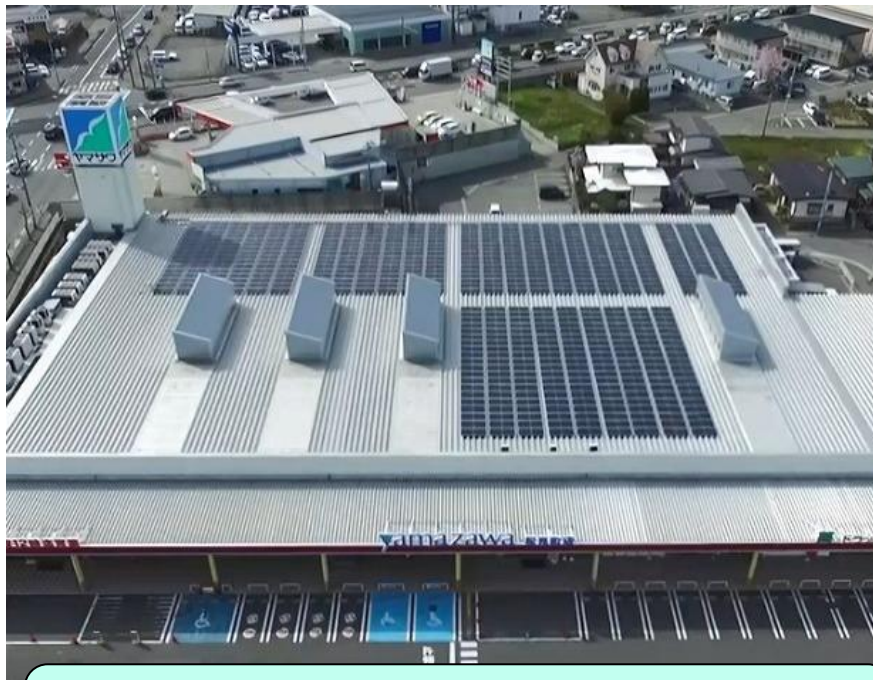
太陽光パネルを設置
